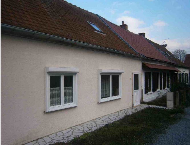
Photos des travaux
