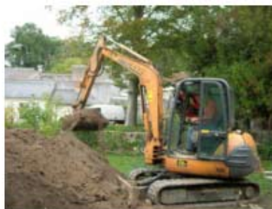
⑤ Mini-pelle creusant la fouille
