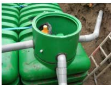
⑧ Raccordement aux gouttières et au réseau d'eaux pluviales
