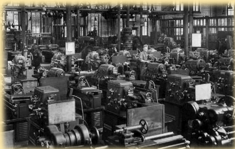
Atelier de mécanique
