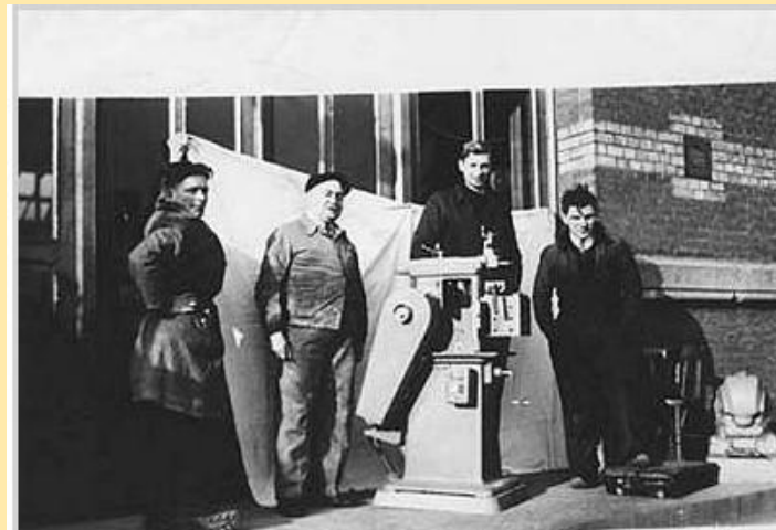
Le fameux étai-limeur construit en série par les élèves
